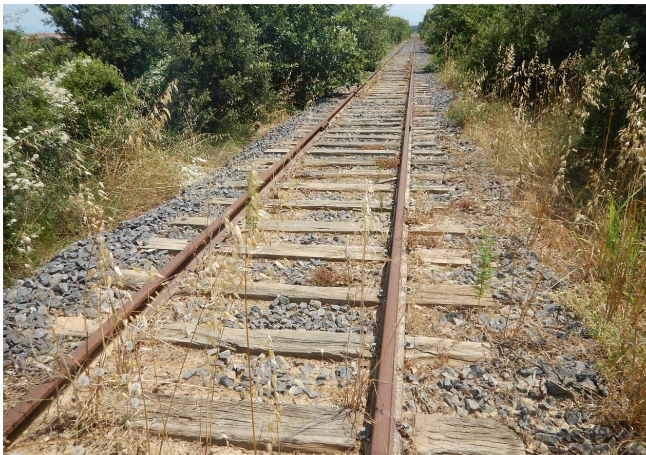
Ci-dessous, vue de la voie vers l'Est : Le merlon est encore présent sous les ronces et s'efface progressivement. La voie est plus fréquemment inondée : des herbes ont poussé sur le ballast devenu « fertile », couchées pas le dernier orage. A droite la dépression arborée fait son apparition.
