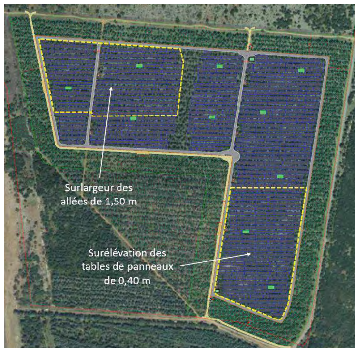
Localisation des différents secteurs de la centrale qui seront comparés
