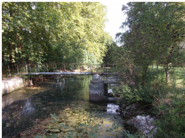
Ancien dispositif de pompage
