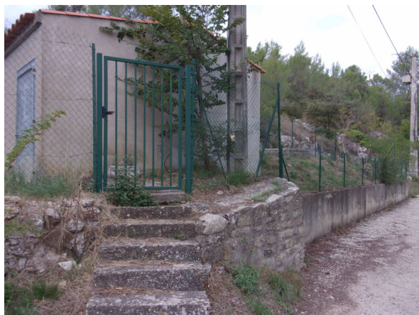
Captage de la source de la vieille église, commune de BELVEZET
