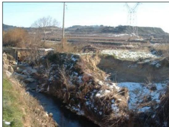
*Pont contourné et érosion de la berge rive gauche au droit du point de retour de la crue (pont de la Gille)*
