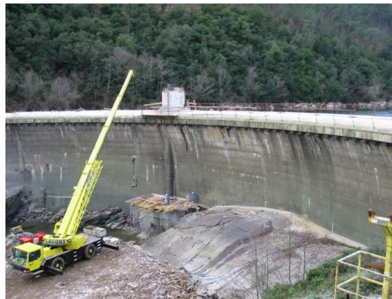
Photographie 4 : Plateforme de travail des travaux de 2002/2003
