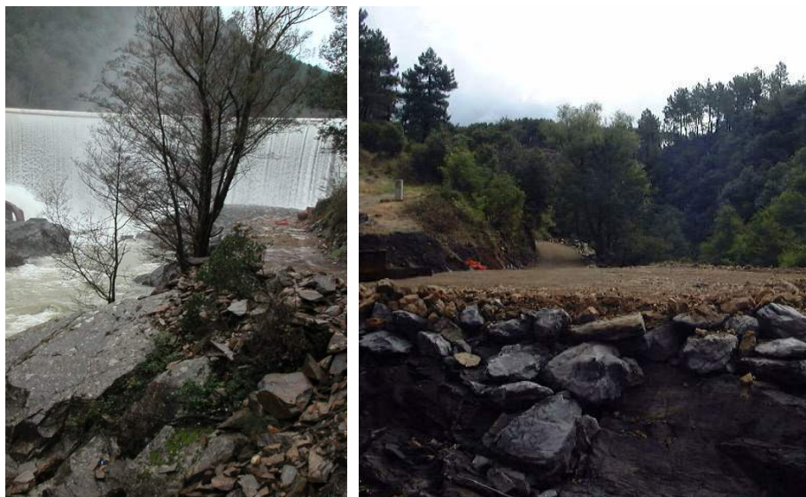
Photographie 5 : Plateforme et piste d'accès créer pour les travaux de 2002 / 2003
