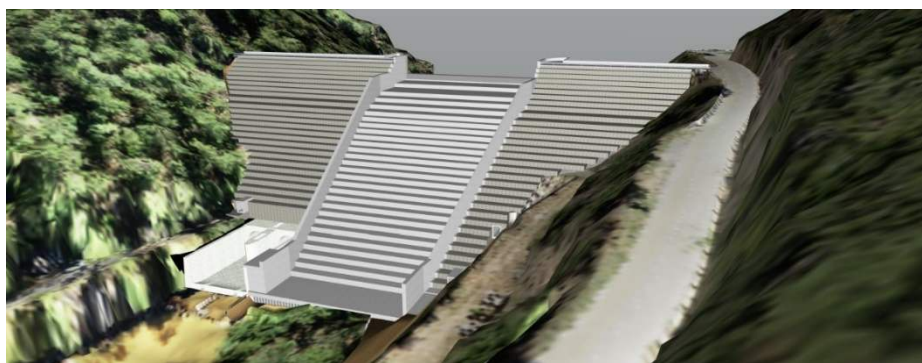
Figure 2 : Vue et schéma de principe des aménagements projetés sur le barrage de Sainte-Cécile d'Andorge (vue sur le parement aval)
