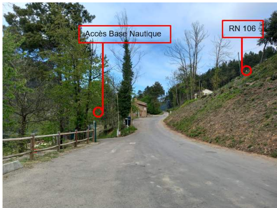
Photographie 3 : Voie d'accès en enrobé menant à la zone d'installation de chantier
