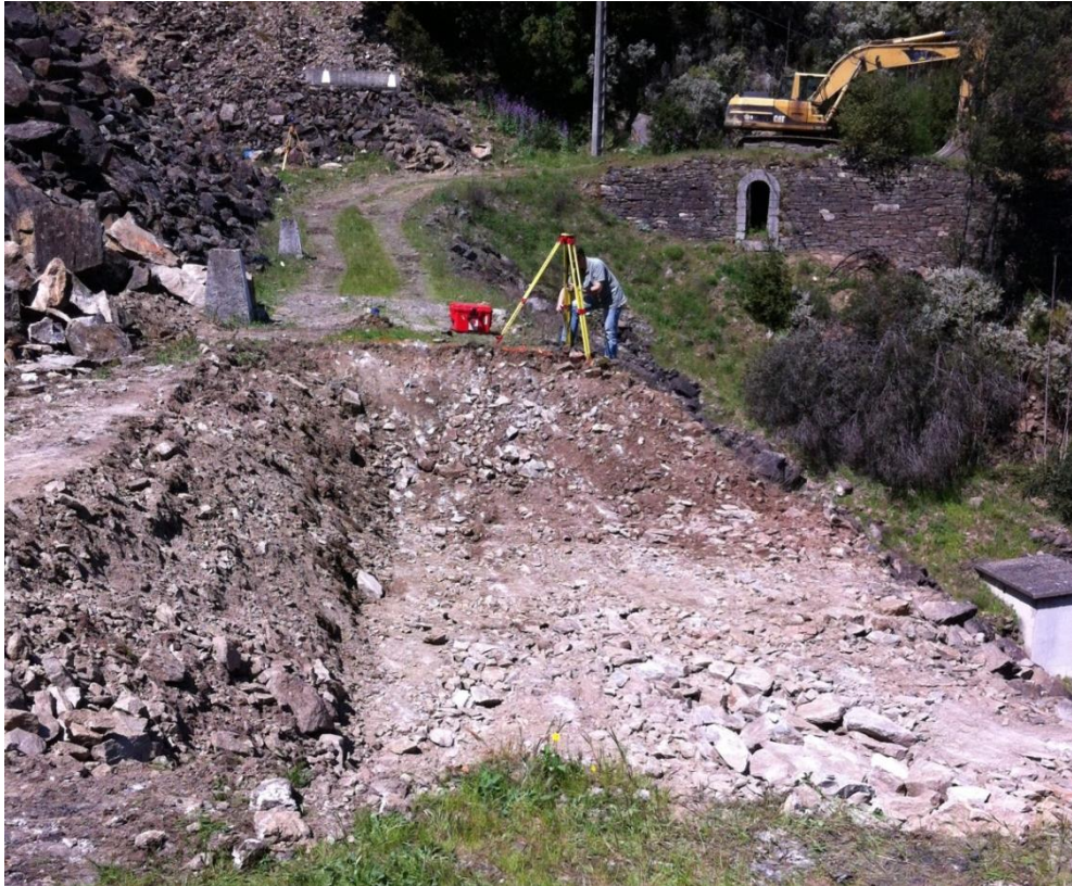
Figure 8 : Tranchée de reconnaissance de grand volume
