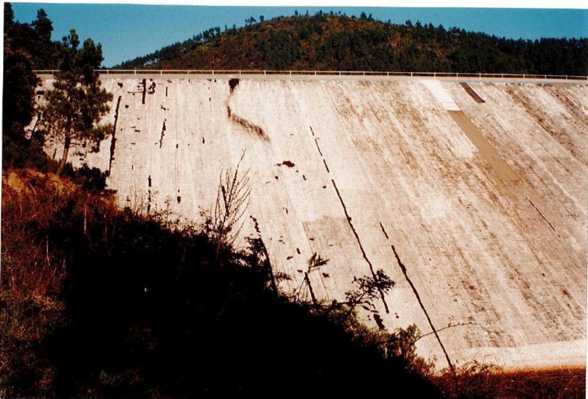
Figure 6 : Etat du masque avant rénovation
