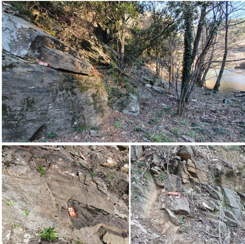
Figure 2 : Affleurements rive gauche en aval direct du barrage
