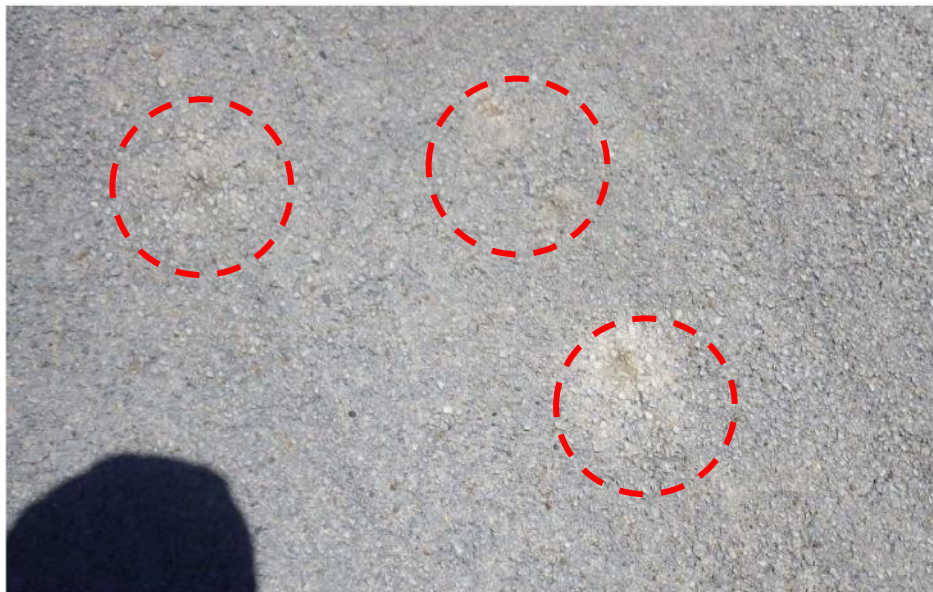
Figure 18 : Cavités identifiées sur le masque
