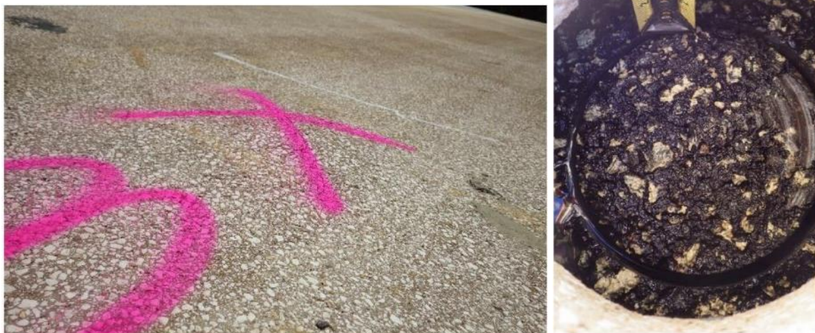
Figure 12 : Cloque ayant fait l'objet du sondage carotté SC3 en 2020 (source [4])
