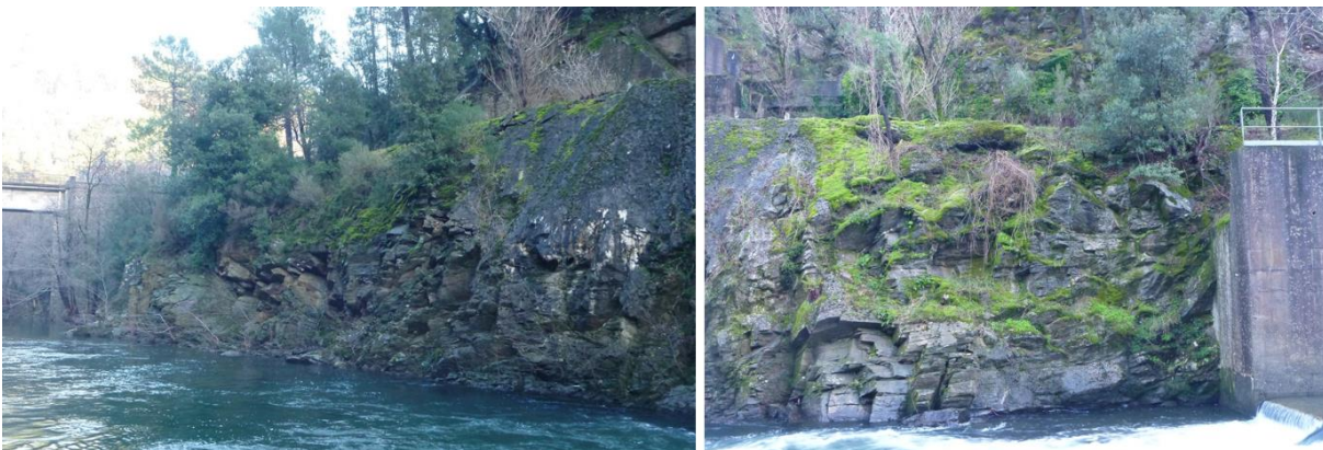
Figure 3 : Affleurements rive droite en aval direct du barrage
