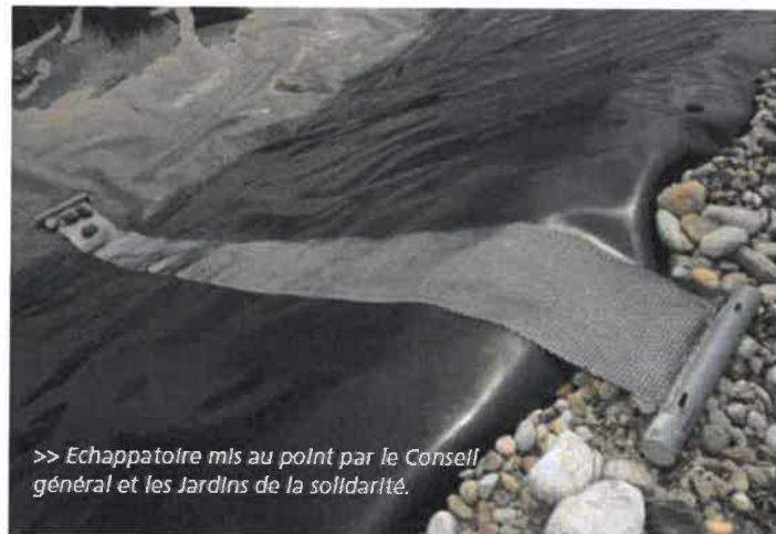
Figure 13 : Exemple d'échappatoire évitant de piéger la petite faune (source : « Neutraliser les pièges mortels pour la faune sauvage »)
