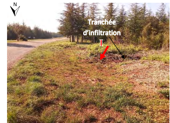
Photographies : GAUCHE : Arrivée des eaux de la piste forestière et de la RD238 qui s'accumulent le long de la route ; DROITE : Tranchée et zone d'infiltration en bordure de la RD238
