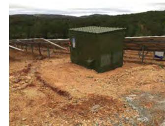
Pour l'installation des locaux techniques, le sol sera légèrement excavé sur une surface équivalente à celle des bâtiments. Une couche de 20 cm de tout venant sera déposée au fond de l'excavation et sera surmontée d'un lit de sable de 20 cm. La base du local reposera sur ce lit de sable.
