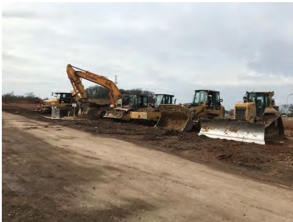
Aire étanche pour l'entretien, le ravitaillement et le parcage des engins mise en place sur le projet de centrale solaire de Pargny-sur-Sault (51 – Marne) (Source : Urbasolar)
