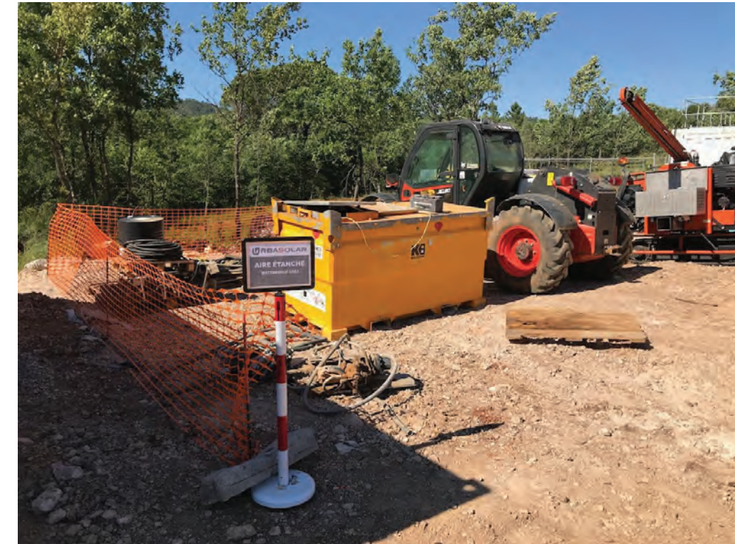
Aire étanche pour l'entretien, le ravitaillement et le parcage des engins mise en place sur le projet de centrale solaire de Bras (83 – Var) (Source : Urbasolar)
