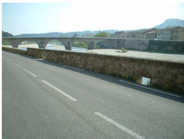
Profil de crête irrégulier et ouvertures
