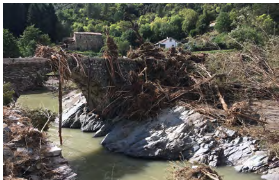
Saint André de Majencoules - Pont du Prat
