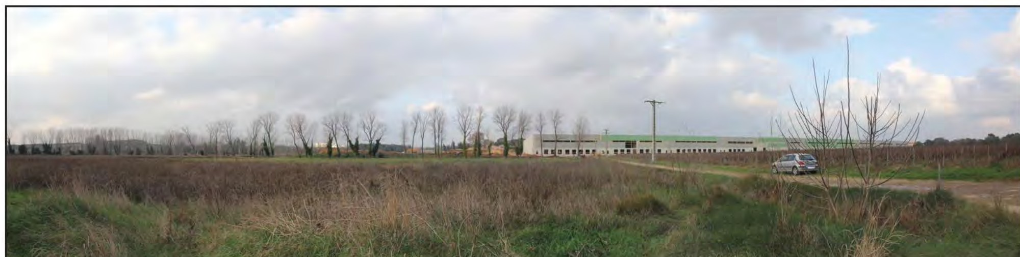
Site (en construction) de la plateforme logistique GOODMAN
