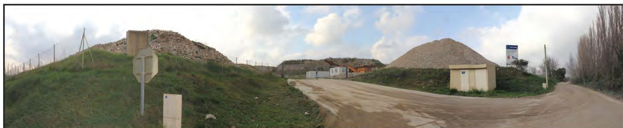
Entrée du site de stockage de déchets du BTP BIOCAMA
