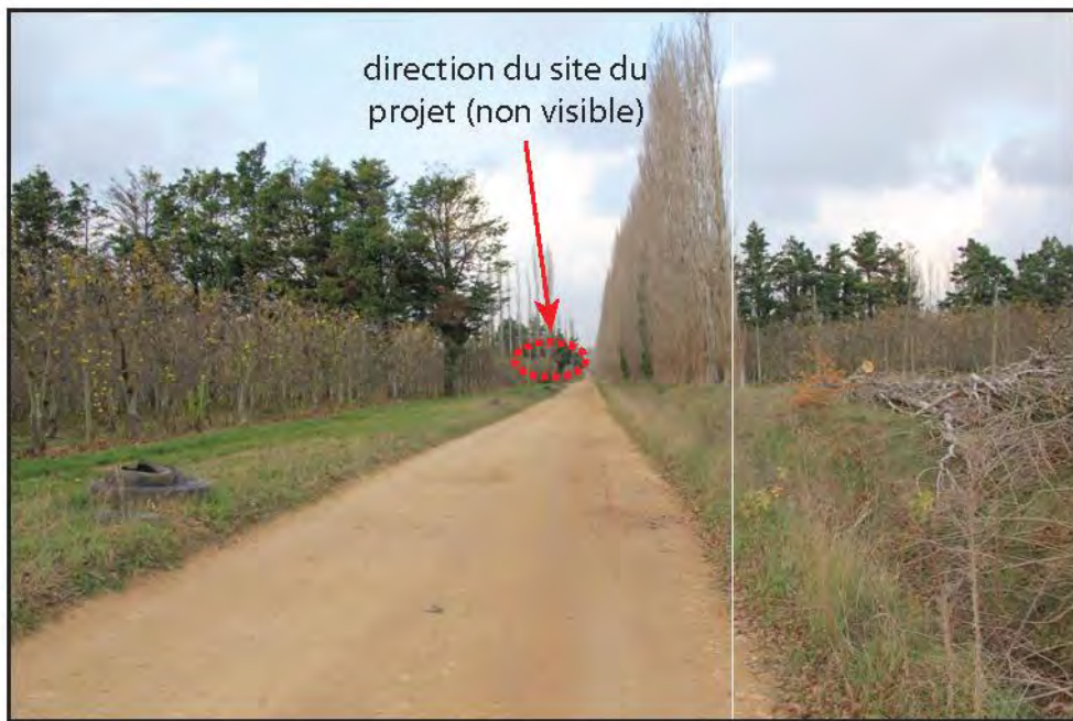
12 - Depuis le chemin d'axe Nord-Sud bordé de vergers au Sud du site
