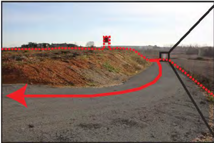
B - Piste d'entrée depuis le premier niveau de la plateforme
