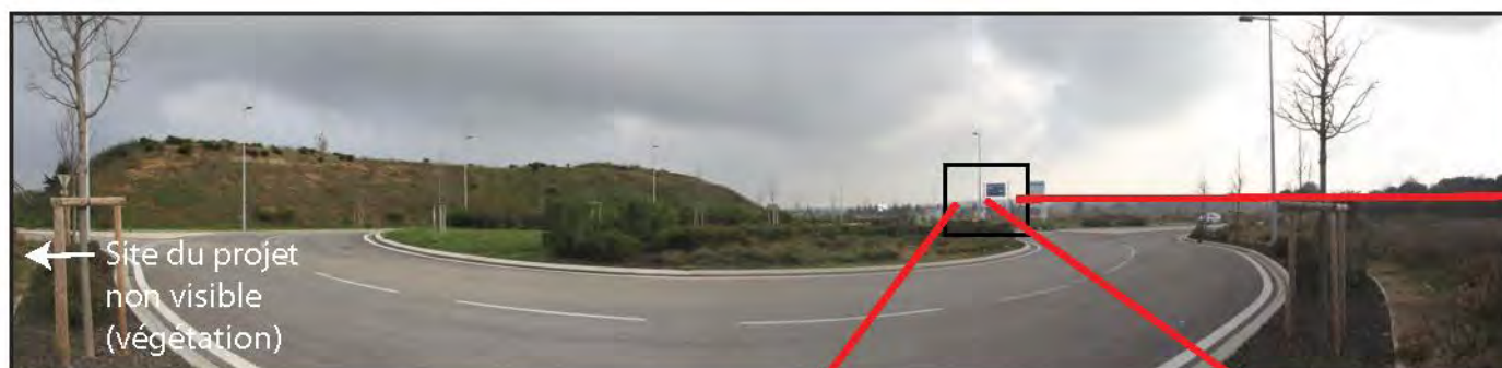
Rond-point aménagé à l'entrée de la ZAC Mitra
