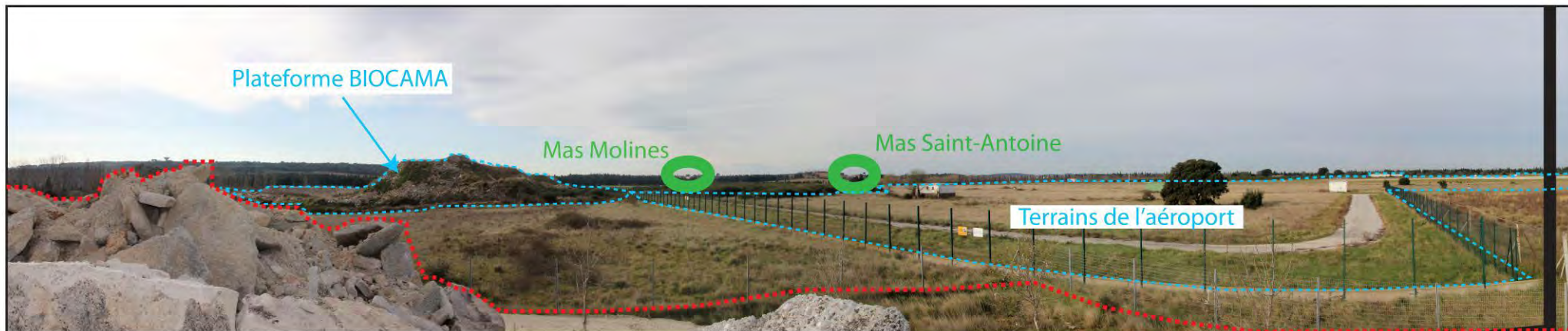
H - Depuis le coin Sud-Ouest (second niveau) en direction du Sud
