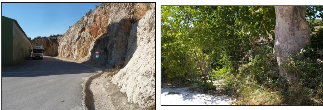
Figure 14 : Photographie d'un fossé longeant la plateforme technique (à gauche) et du bassin de décantation grillagé (à droite) - source : ATDx
