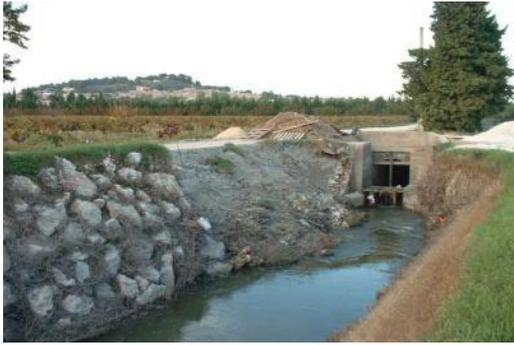
entrée du tunnel de l'étang (effondrement en rive gauche)\*
