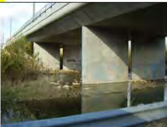
7 roubine des fontaines ouvrage SNCF
