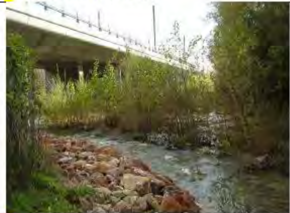
6 zone boisée en amont ouvrage TGV
