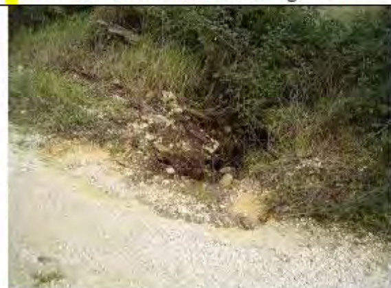
8 déversement sur chemin endigué érosion
