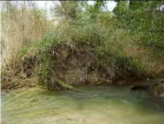
3 Digue environ 1,70m après rupture
