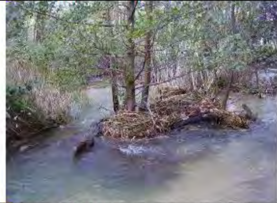
4 en aval de la brèche
