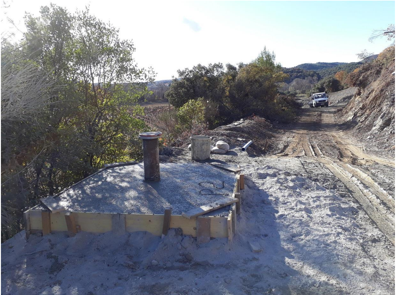
Vue du piézomètre P2 (avant peinture)
