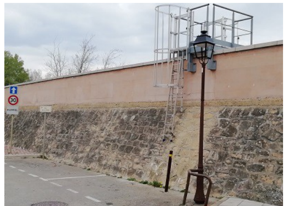
Surélévation de l'ancienne digue zone F-NU
