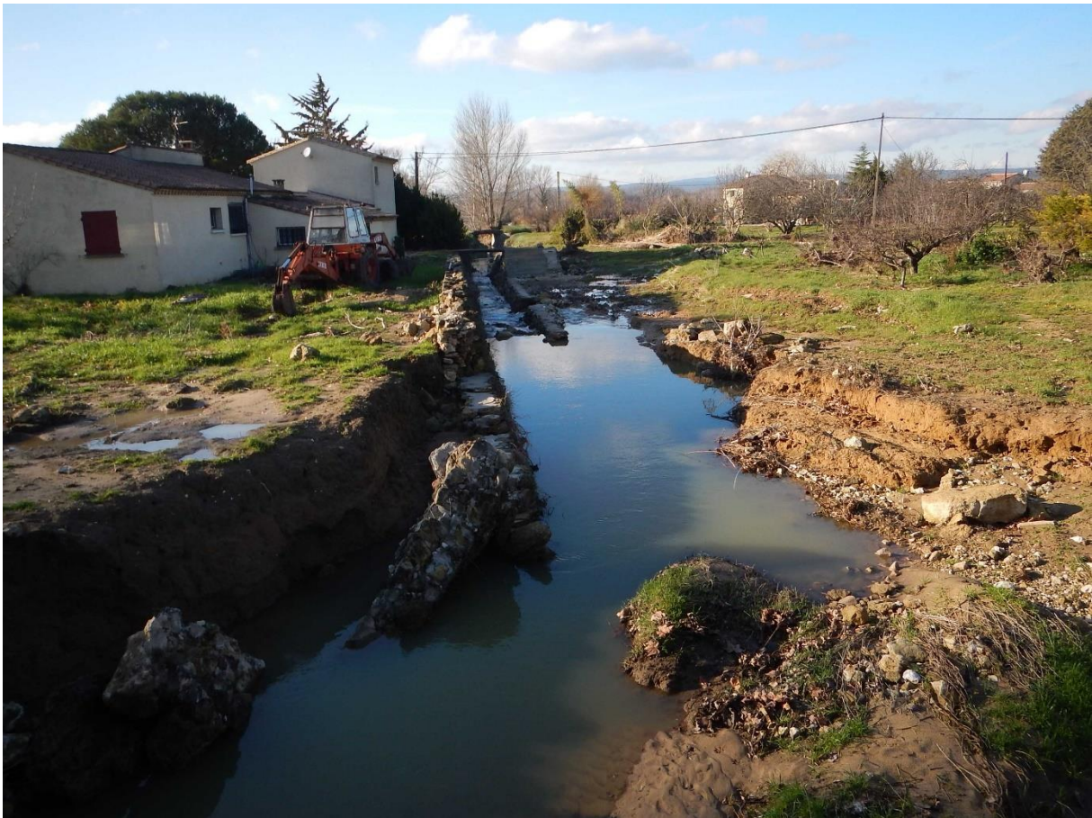
Traversée du Merlançon au niveau du hameau du Moulinas, sur la commune de Saint-Siffret
