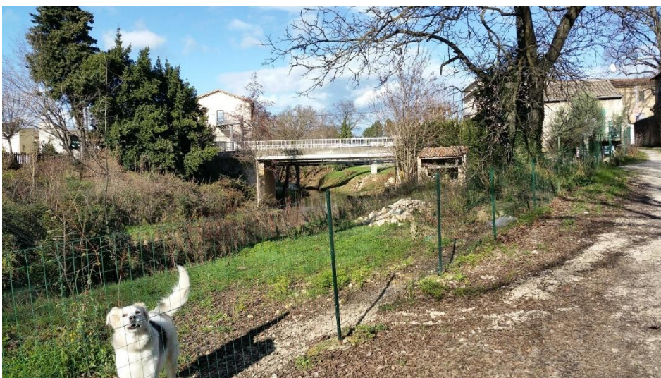
L'Alzon à Uzès – vue vers l'amont
