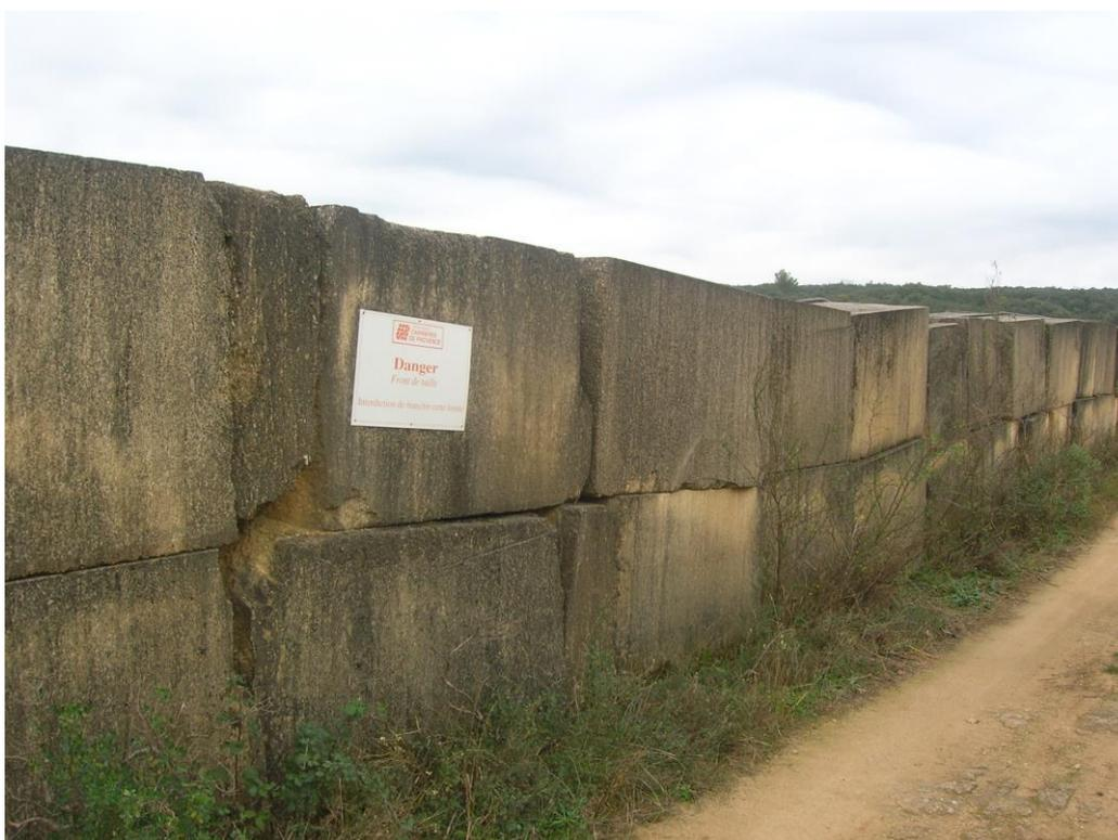
**Figure 1 : Clôture de blocs encadrant le site d'exploitation interdisant l'accès et signalétique mise en place**
