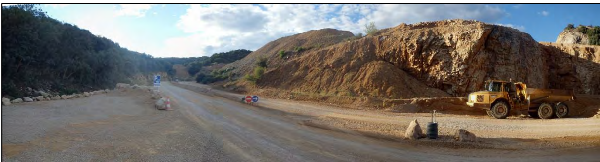
Photographie 5 : Piste (vue derrière la base de vie avec un parking à gauche et un bassin d'infiltration à droite)
