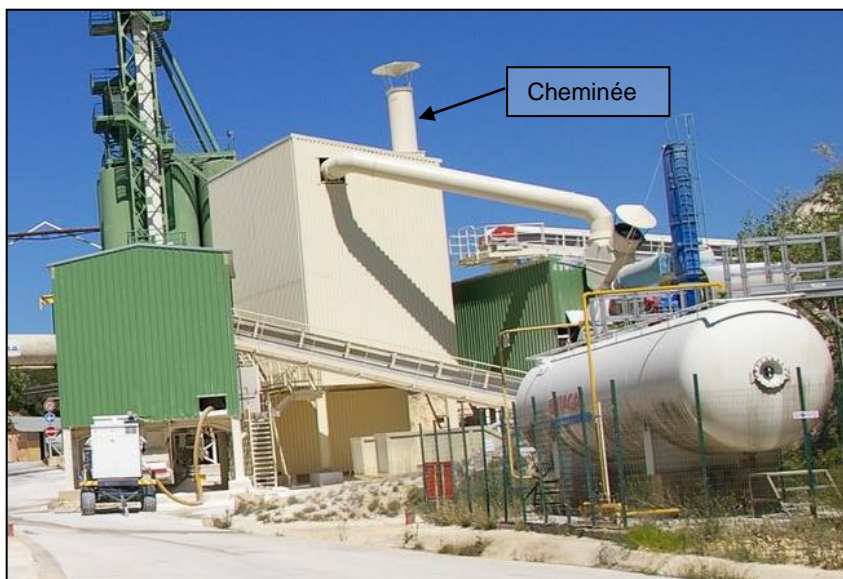
Photographie du four de séchage (bâtiment blanc) de l'usine PROVENCE SA à Pouzilhac (source : ATDx)
