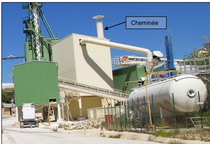
Photographie du four de séchage (bâtiment blanc) de l'usine PROVENCALE SA à Pouzilhac (source : ATDx)
