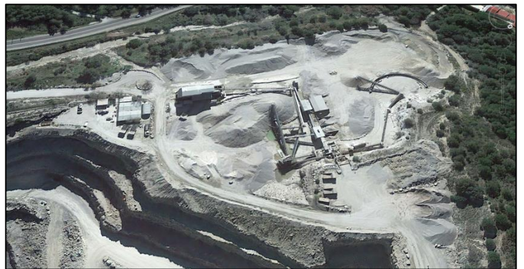
Installations de traitement de la carrière (Source : Google)Earth
