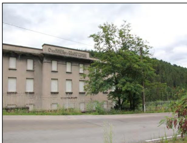
Ancien bâtiment, Compagnie des Mines de la Grand'Combe
