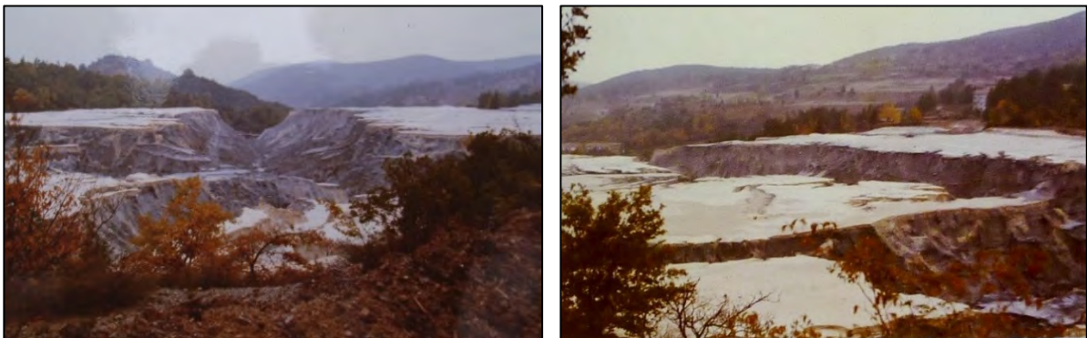
Photographies 6 et 7: Vues de la crevasse principale et d'une crevasse latérale apparue suite aux épisodes cévenols de l'automne 1976 (archives DREAL 5.4.10)
