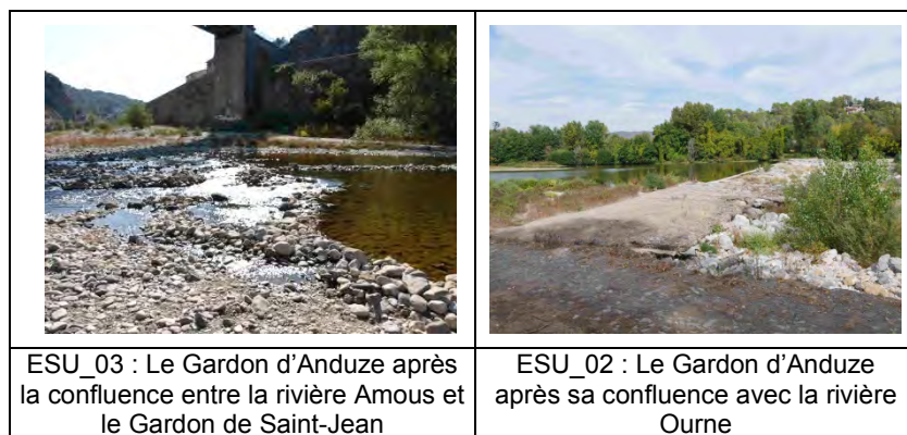
Photographies 48 et 49 : Points de prélèvements d'eaux superficielles sur le secteur aval - Gardon d'Anduze en période d'étiage (source : GEODERIS, octobre 2017)
