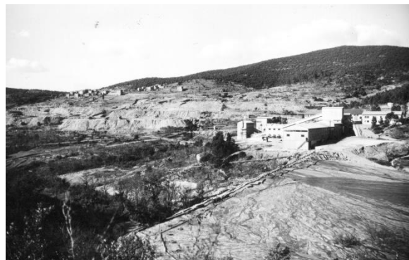
SSA, vue du dépôt, de l'usine et de la MCO en 1959 (arch. DREAL 5.4.9)
