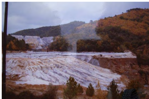
photo n° 11 : digues n° 1 et 2. Vue des fronts de digue. (Arch. DREAL 5.4.10)
