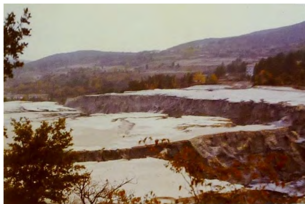
photo n° 7 : digue n° 1. Vue de la crevasse principale et d'une crevasse latérale, (Arch. DREAL 5.4.10)
