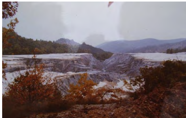
photo n° 2 : vue en long de la crevasse principale de la digue n° 1 (26/10/1976) (Arch. DREAL 5.4.10)
