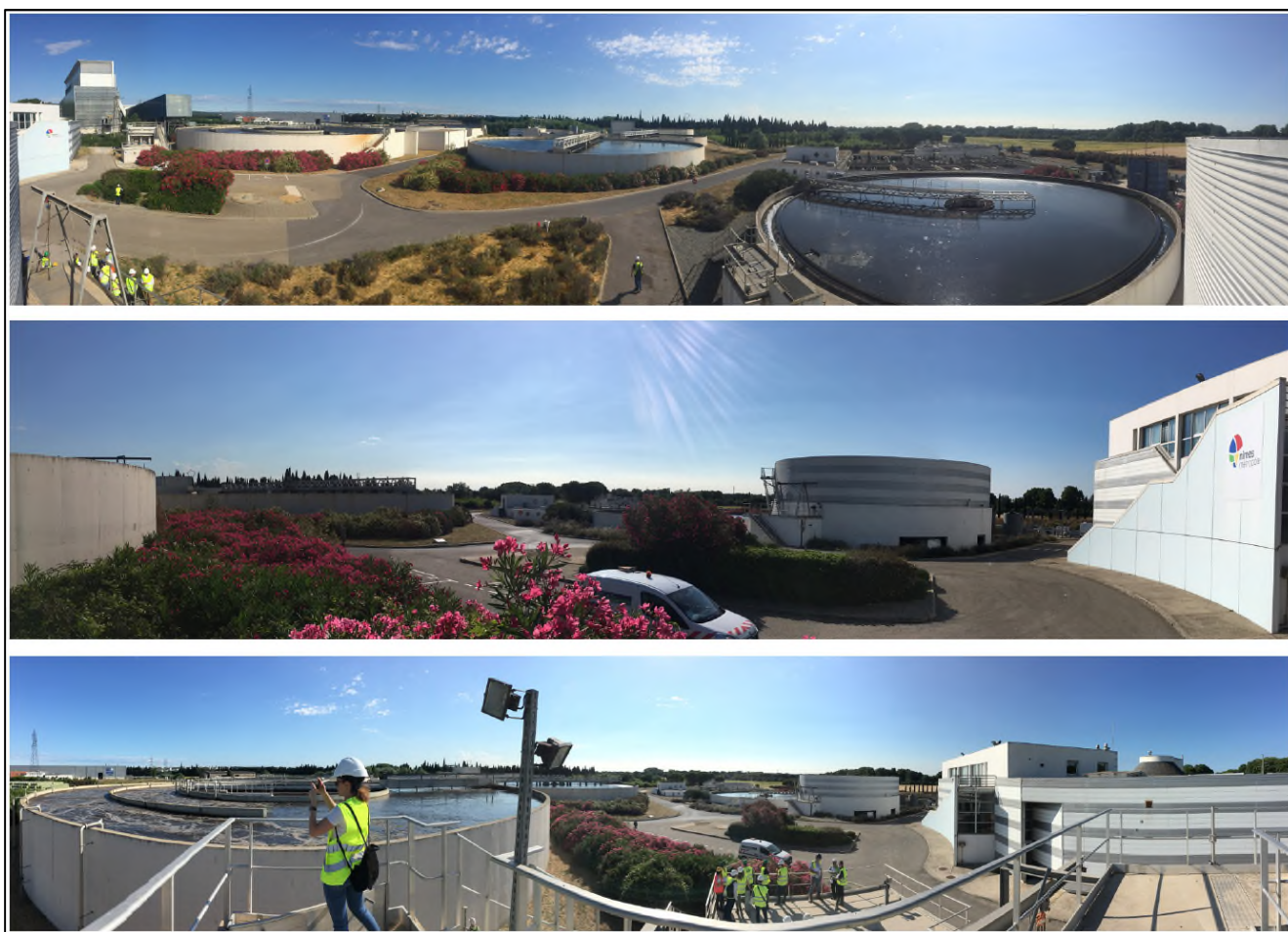
Figure 59 - Photographies du site de la STEU dans son environnement proche avant travaux débutés en juillet 2020
